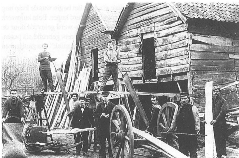
De houtzagerij van Alfons De Wulf, later van Gentil De Wulf in Merendree. Met de trekzaag worden de planken op maat gezaagd.
